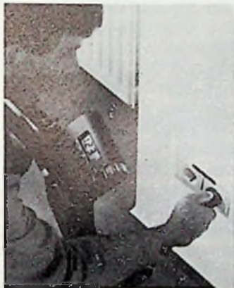
Bild 1: Schleifenwiderstandsmessung an Schutzkontakt-Steckdosen
