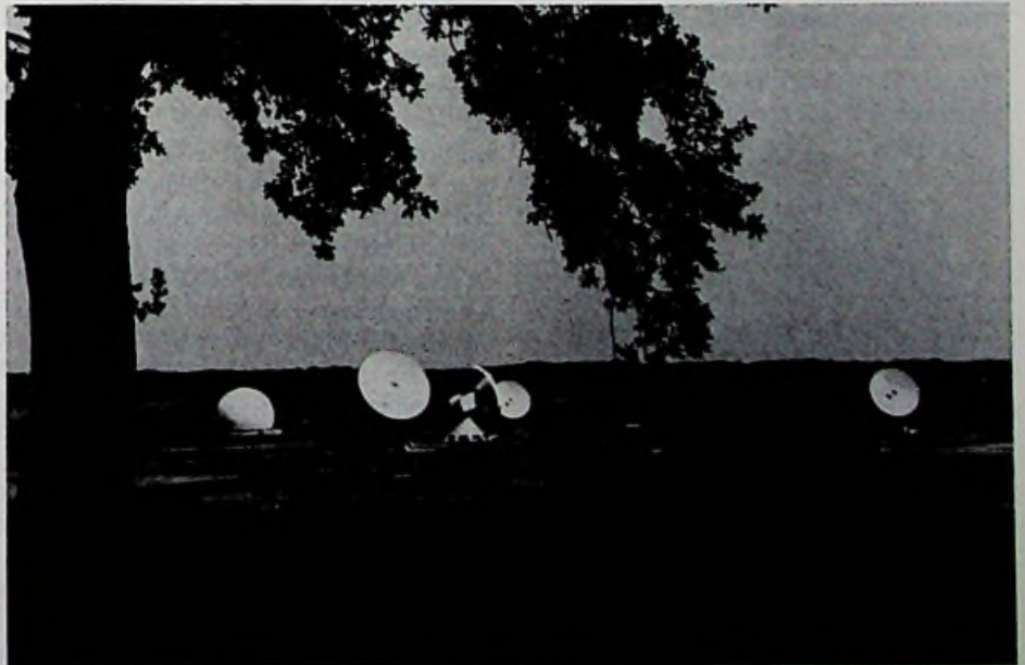
Bild 1: Die 5 Antennenanlagen der Erdfunkstelle Raisting. Im Hintergrund die erste Anlage mit dem Radom als Wetterschutz (Siemens-Pressbild)
